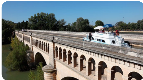
PUENTE-CANAL DEL ORB
